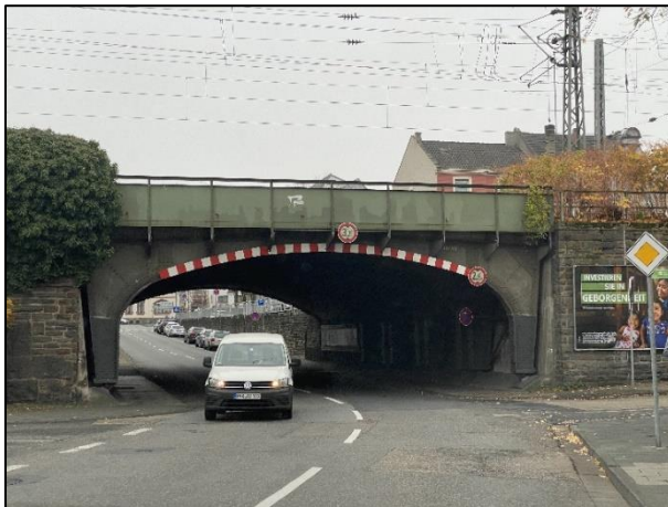
Unterführung Heddesdorfer Straße (eigene Aufnahme)
