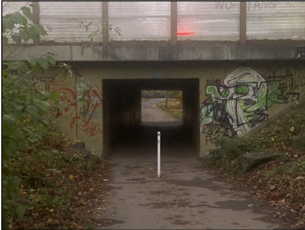
Unterführung Fliedergarten in Richtung Abenteuerspielplatz (eigene Aufnahme)
