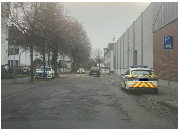
Schlechte Oberflächenqualität Fahrbahn Reckstraße (eigene Aufnahme)
